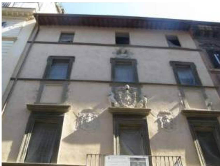
Facciata su via Giulia, in fase di completamento
