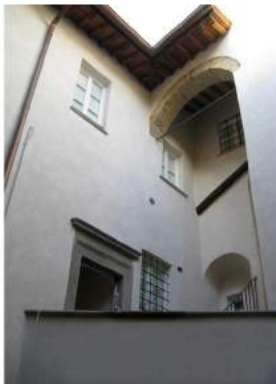
Facciate sulla chiostрина - post operam
