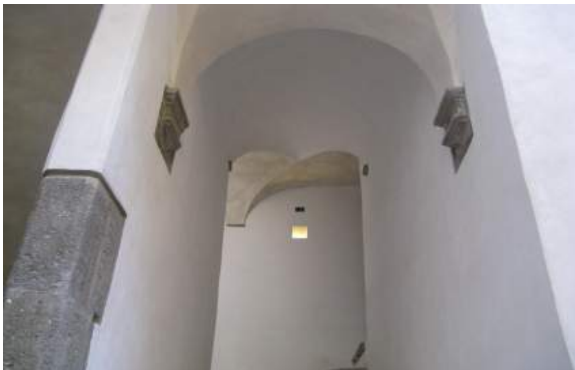
Dettaglio del corpo scala dopo il restauro
