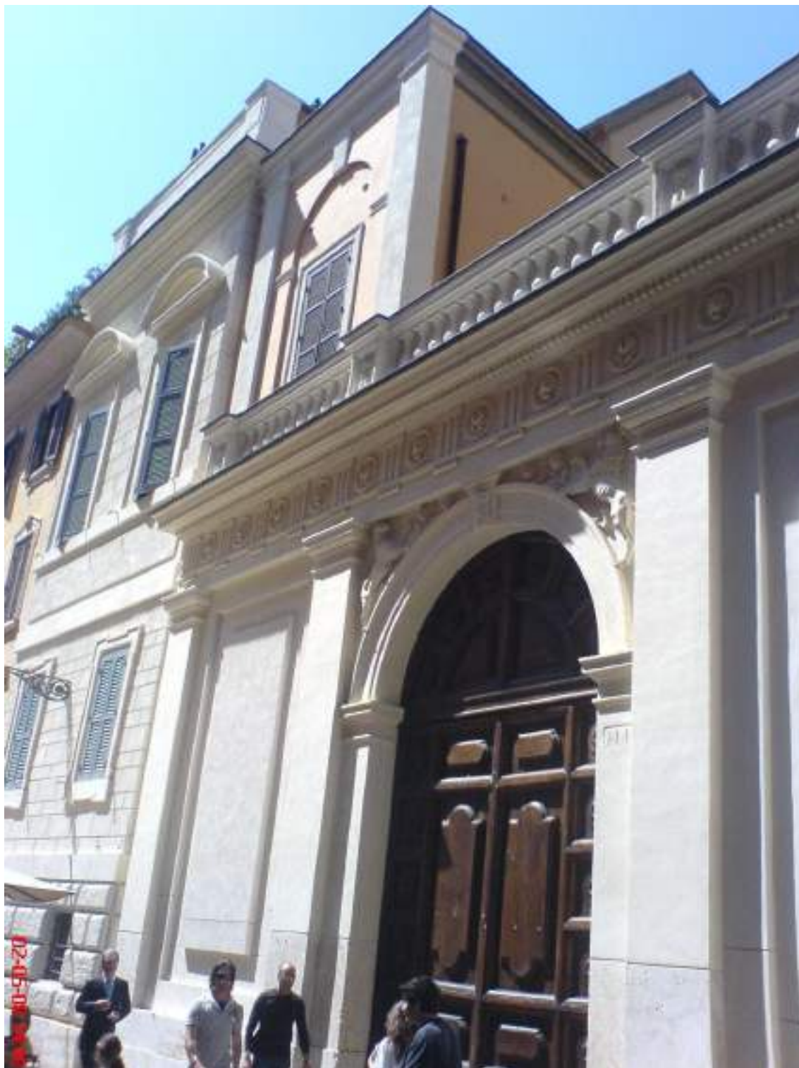
Facciata su via Frattina ad intervento realizzato
