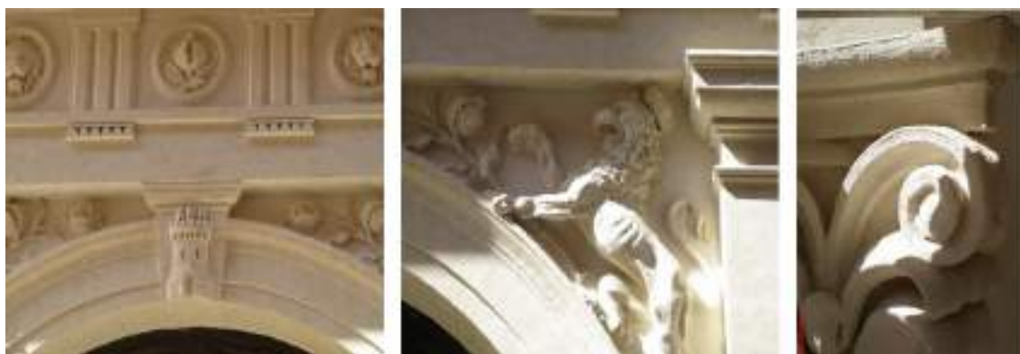
Dettagli delle finiture degli elementi decorativi restaurati
