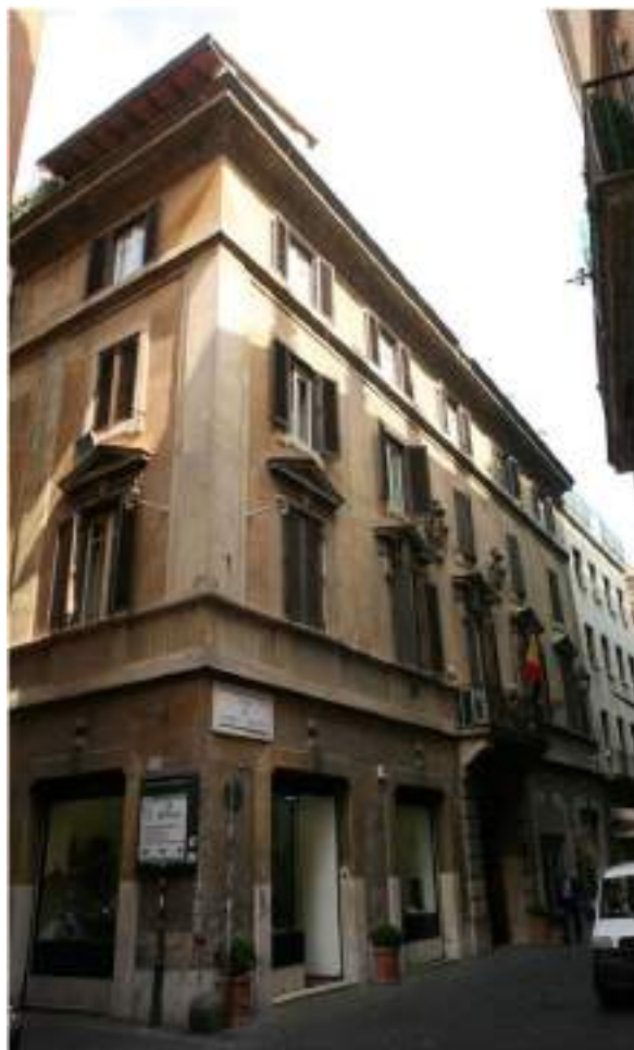
Facciata su Via di Campo Marzio ante operam
