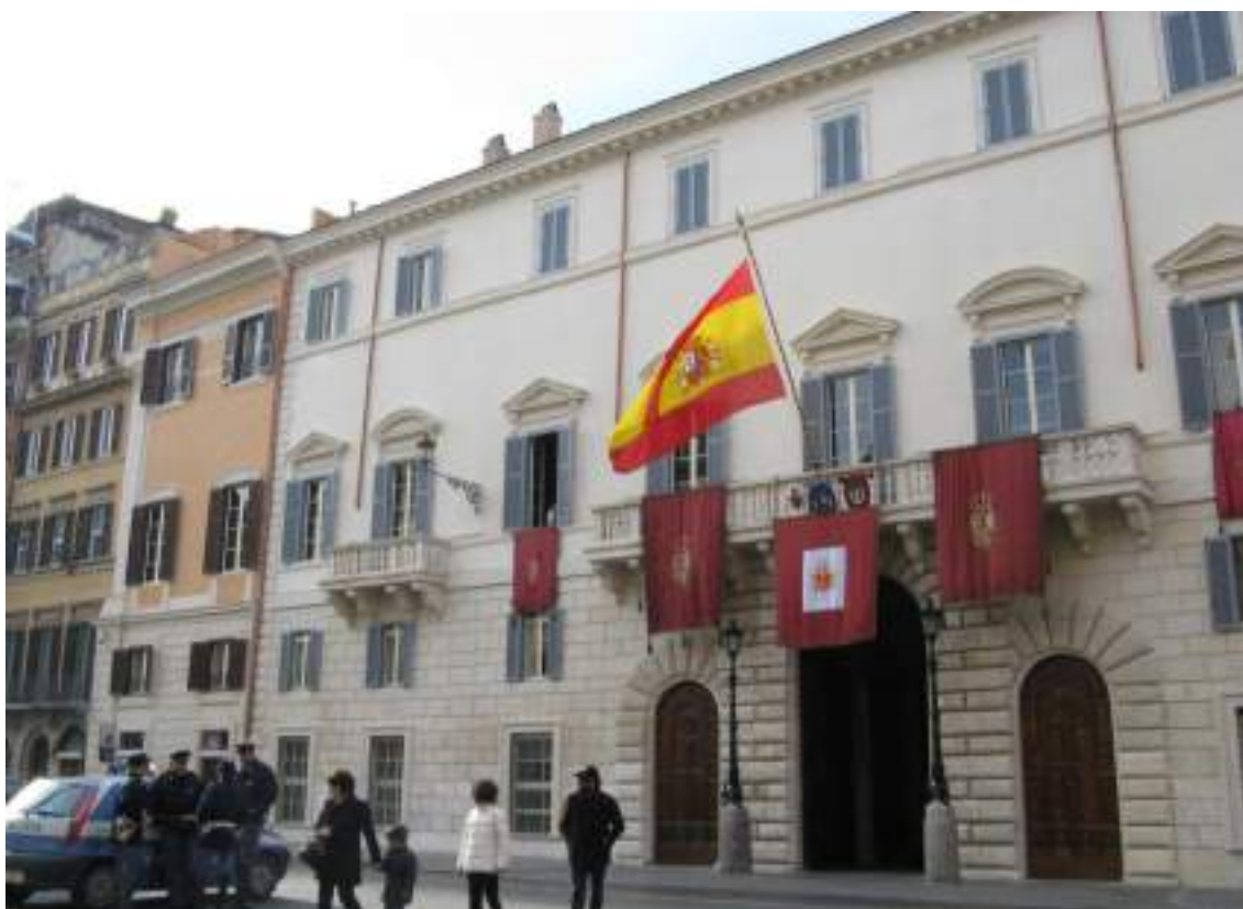
La facciata su piazza di spagna – post operam
