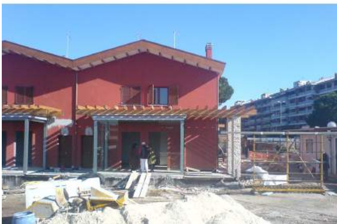
EDIFICI IN CANTIERE, IN FASE DI ULTIMAZIONE
