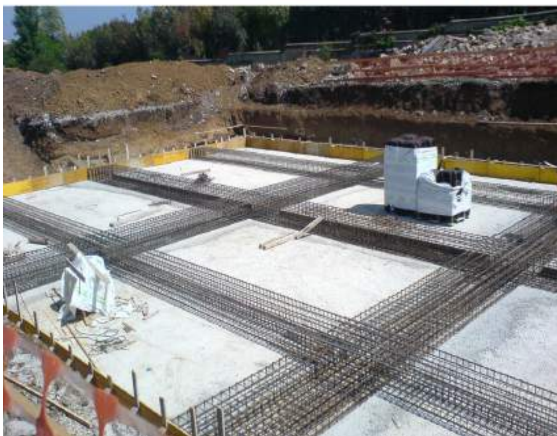
FOTO DI CANTIERE
