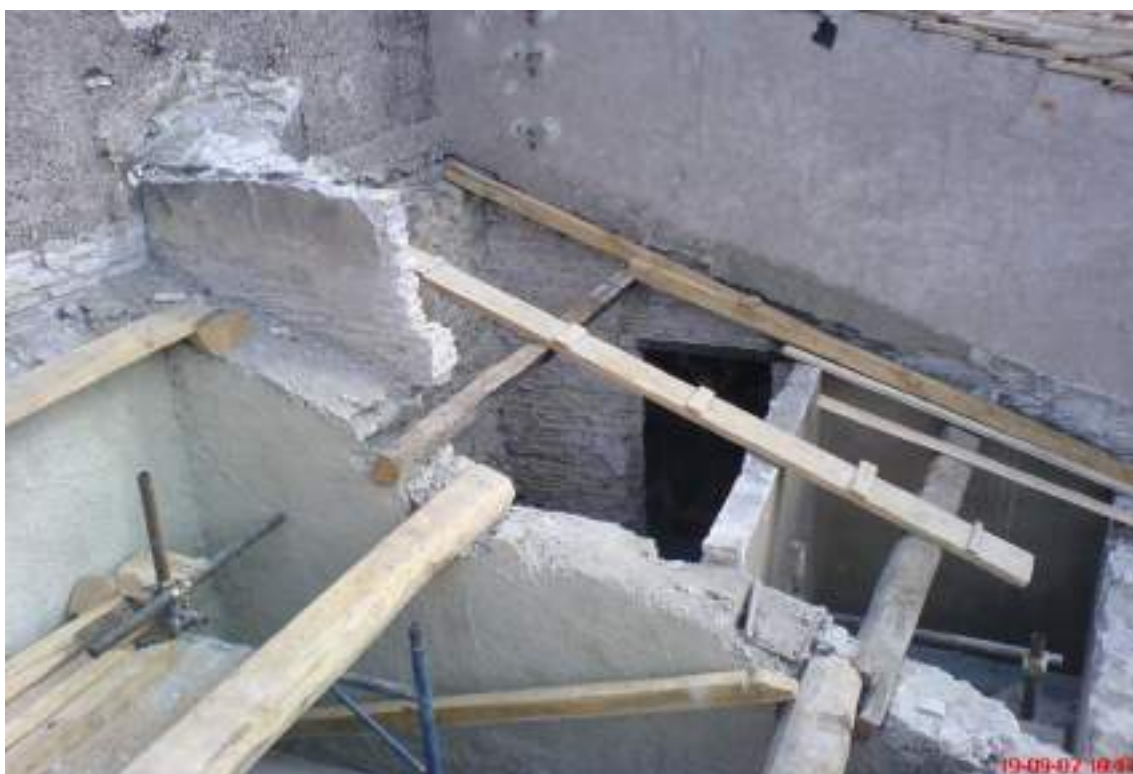
Facciata su via Giulia, in fase di completamento
