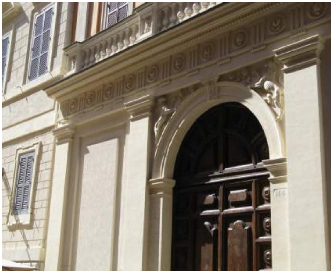
Dettagli del portale restaurato su via Frattina
