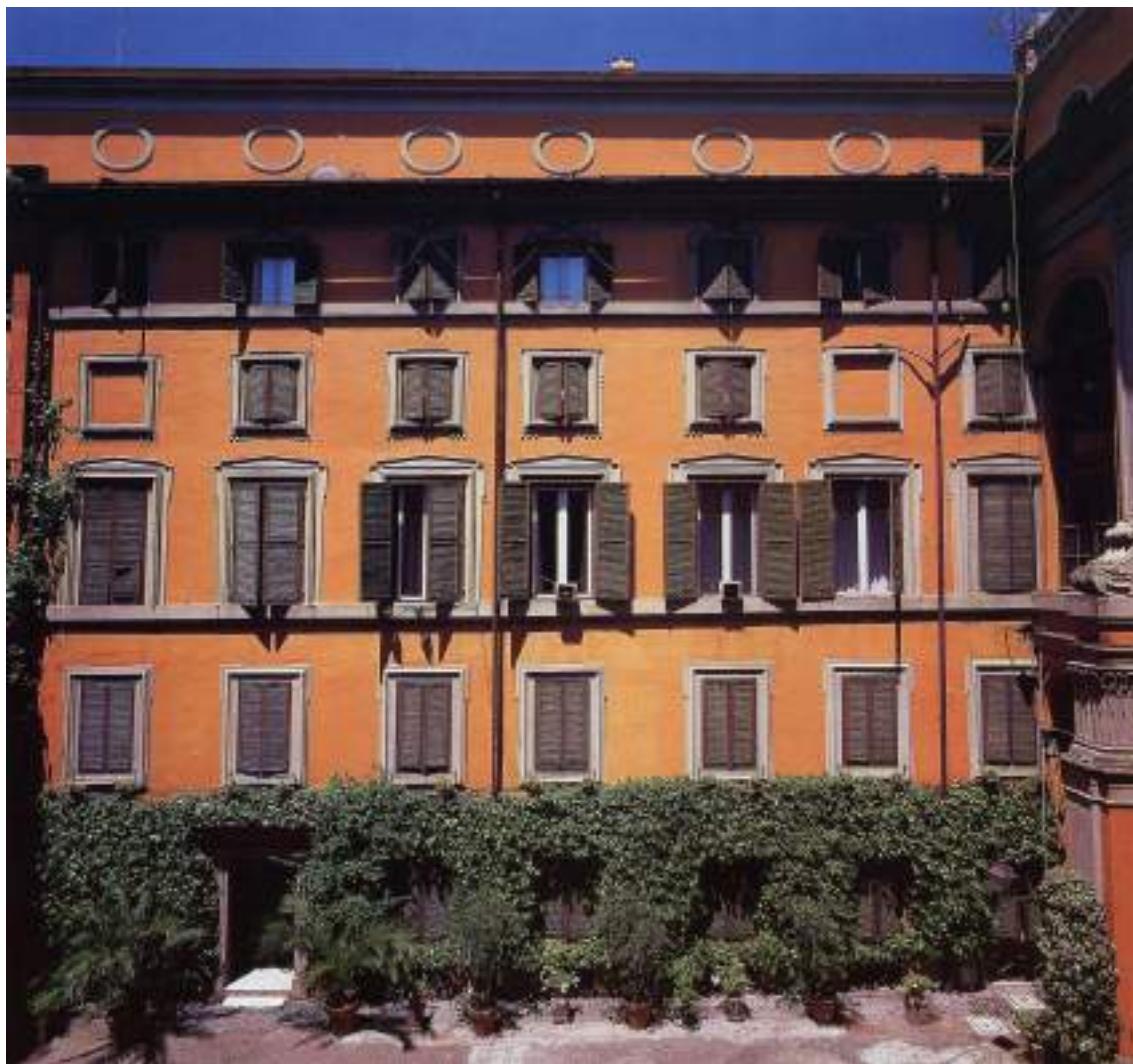
Vista della Corte principale – ante operam
