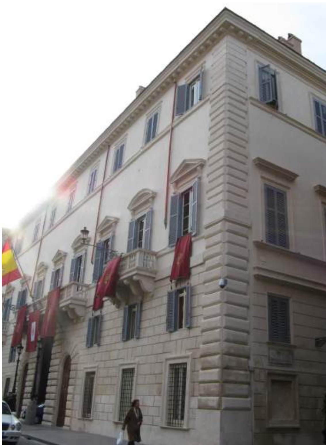
Facciate su piazza di Spagna e via Borgognona ad intervento realizzato
