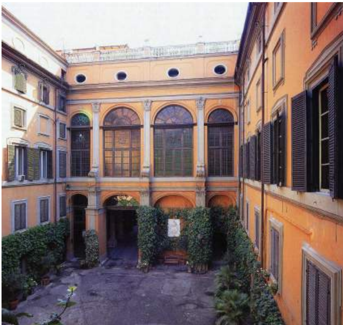
Vista della Corte principale – ante operam
